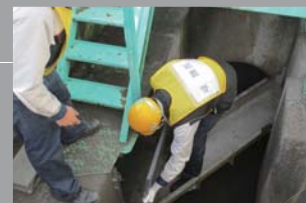
農業用水取水口への蓋の取り付け
