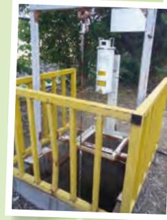
南海工場に設置した油膜検知器
